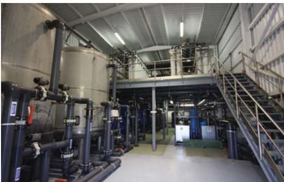
Figura 3. Interior de la nave de proceso
