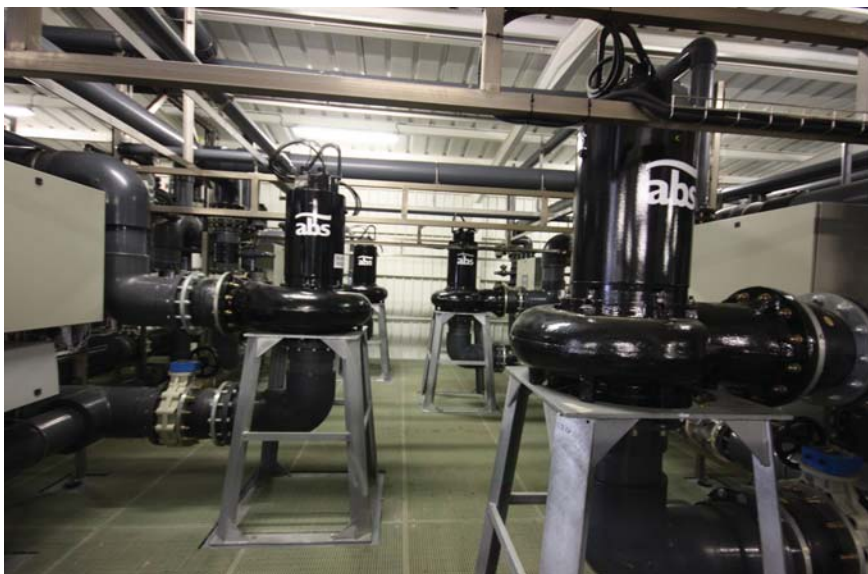
Figura 7. Bombas de recirculación del funcionamiento en cross flow , suministradas por ABS
